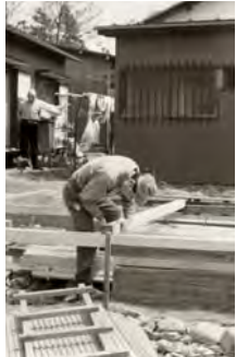
社屋建設風景
