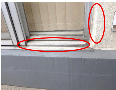
図2-3 シーリング材例
