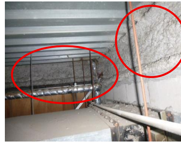
図2-7 吹付け材（耐火被覆材）例
