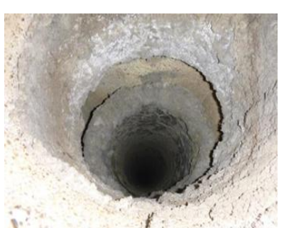
図2-6 煙突断熱材例
