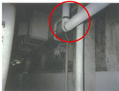
図2-4 配管エルボ保温材例
